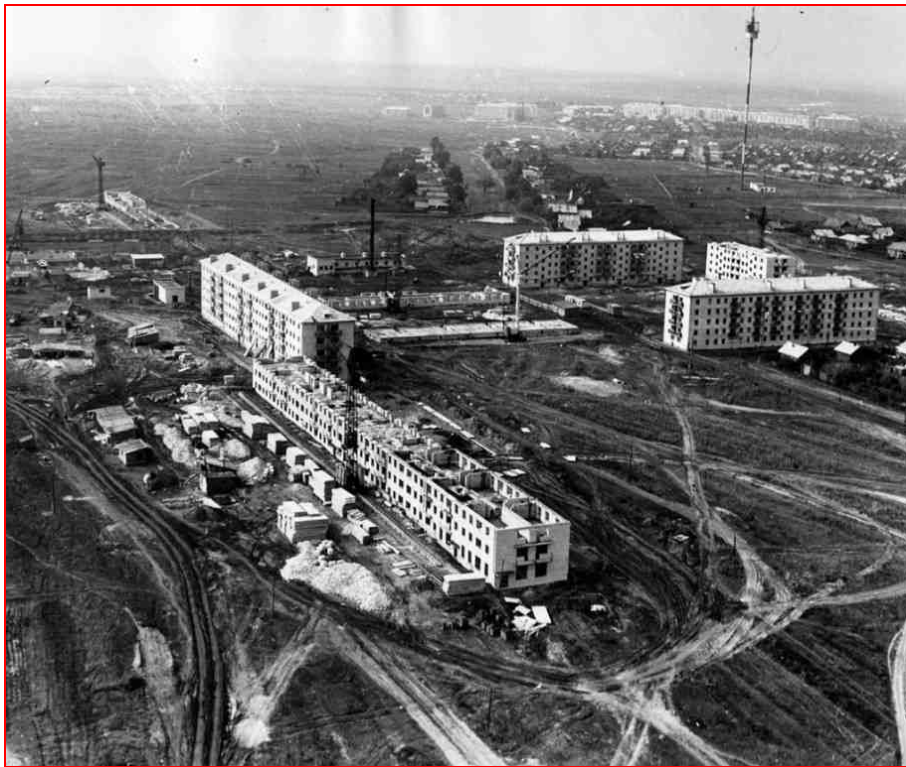
Начало строительства 623 квартала. На заднем плане деревня «Салтаниха»
