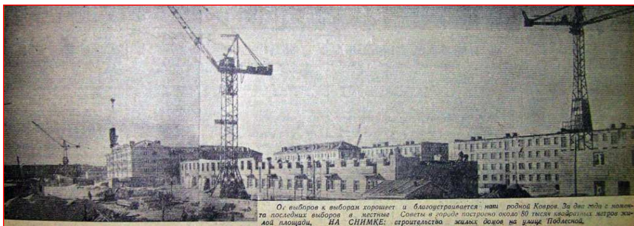
Строительство жилых домов на ул.Подлесной [«РК», 01.03.1961]
