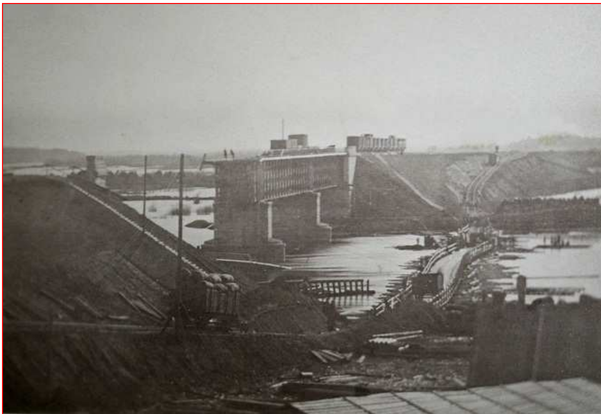
Мост через Клязьму у станции Ковров-1 после обрушения двух пролётов (фото мая 1867 г.) Слева виден временный деревянный мост на плотках, по которому по одному спускают вагоны
